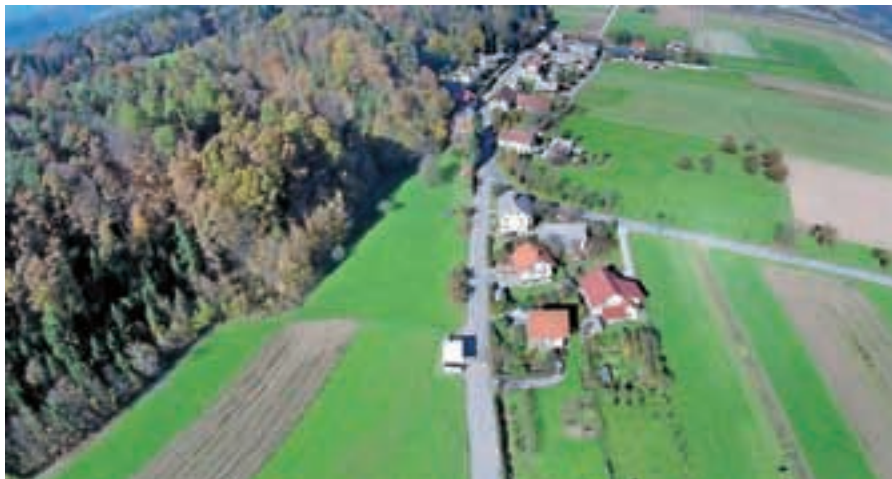
Zgrajeno kanalizacijsko omrežje na območju Podbrezj (Srednja vas) v občini Naklo
