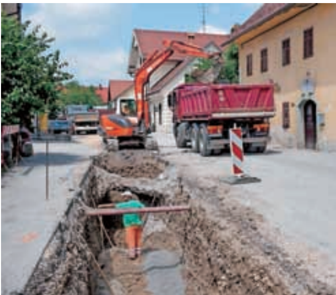
Gradnja kanalizacije v osrednjem delu Cerklj
